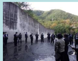
美和ダム土砂バイパストンネルも視察
