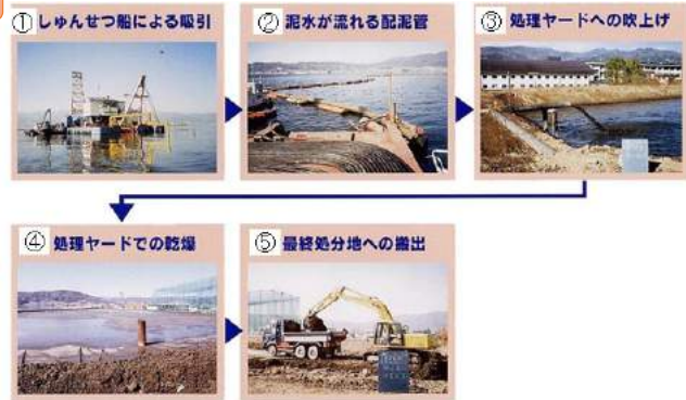
諏訪湖の浚渫の様子
