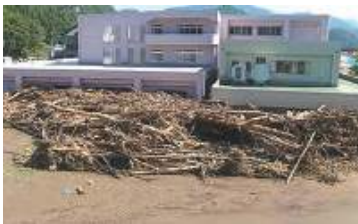
被災した要配慮者施設 (岩手県)
