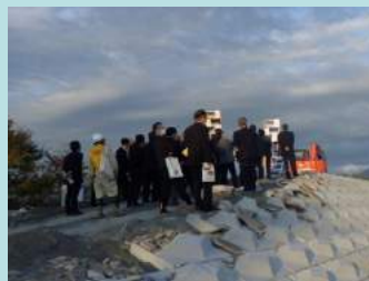
R2.7豪雨で被災した三峰川の堤防にて、当時の状況・国土交通省の動き・市町村との連携について説明
