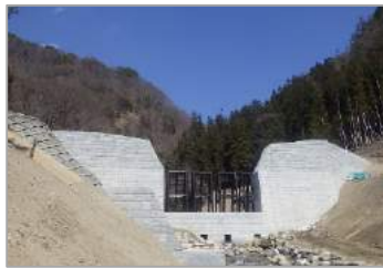
滝沢第2砂防堰堤（大鹿村・中川村）
