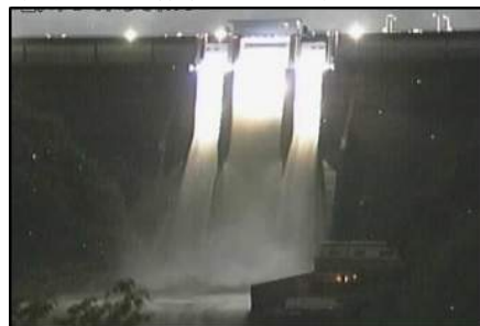
美和ダムの放流状況 (10月12日22:19)
