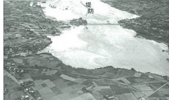
飯田市松尾の破堤状況
