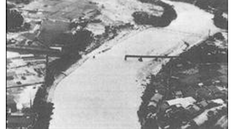
落橋したJR飯田線鉄橋
