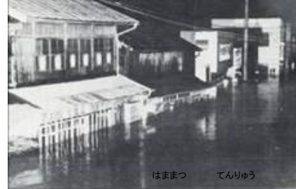
浜松市天竜区の被災状況
