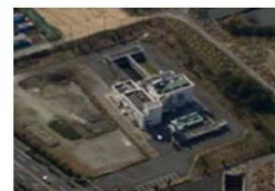
浦安ポンプ場 平成27年3月 356m 3 /min増強 排水能力 792m 3 /min
