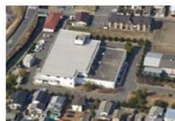
当新田ポンプ場 平成28年3月 305m 3 /min増強 排水能力 955m 3 /min
