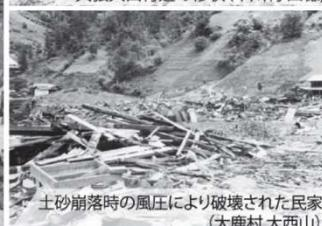
土砂崩落時の風圧により破壊された民家(大鹿村 大西山)
