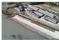
堤防整備 (宮田村 大久保地区)
