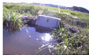
田んぼ貯留実証実験の様子
