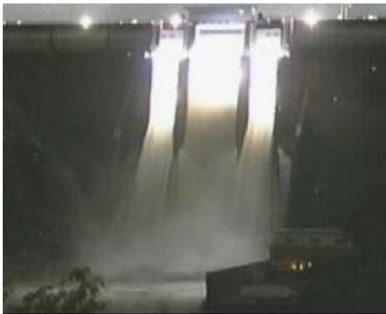
令和元年 美和ダム緊急放流
