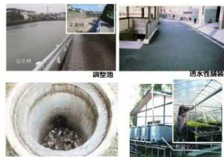
雨水貯留浸透施設の例
