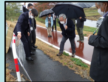
R2.7月出水により三峰川で堤防欠損した箇所、急流河川での被災特性を確認
