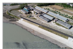
堤防整備 (宮田村 大久保地区)
