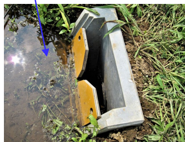
水位調整板の設置イメージ
