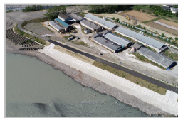
堤防整備 (宮田村 大久保地区)
