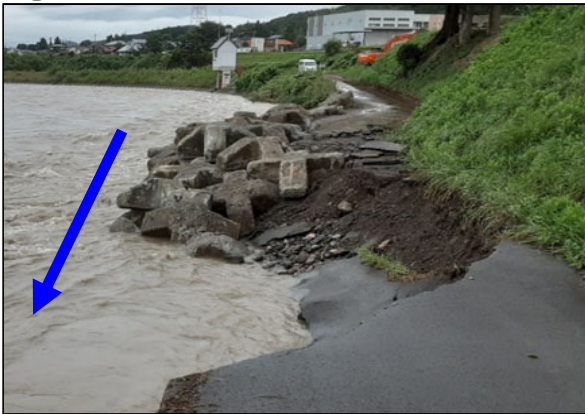
8月16日6:00 応急復旧状況(欠損箇所)
