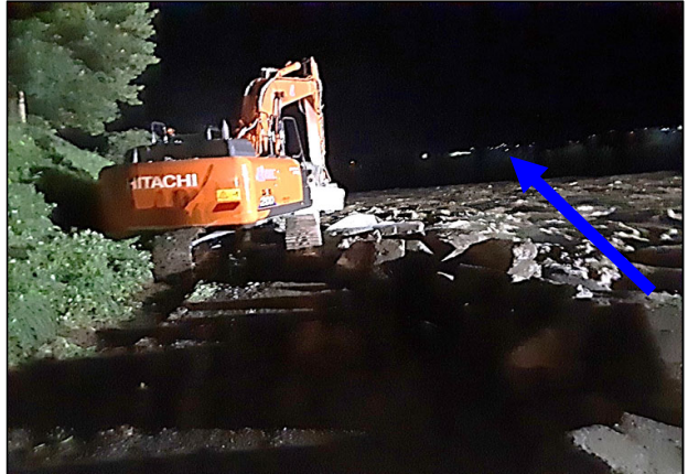
8月15日21:00 応急復旧状況(欠損箇所)
