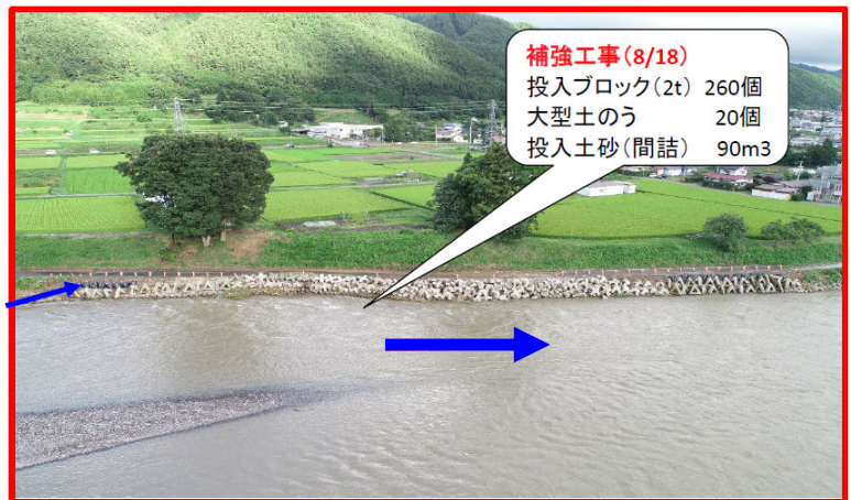
8月18日17:00 補強工事完了 (欠損箇所の上下流を補強)
