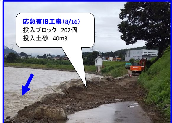
8月16日17:00 応急復旧工事完了(欠損箇所)
