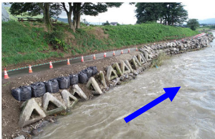
欠損箇所上下流での河岸侵食を防ぐため補強工事を行いました。
