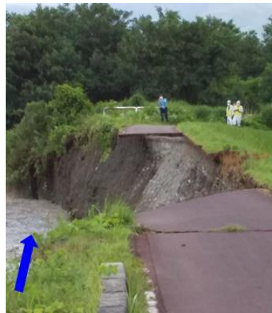
近年の河岸侵食の被災写真（左：天竜川、右：三峰川）
