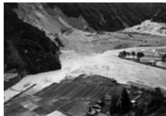
昭和36年6月梅雨前線豪雨災害【土砂崩壊(大鹿村)】
