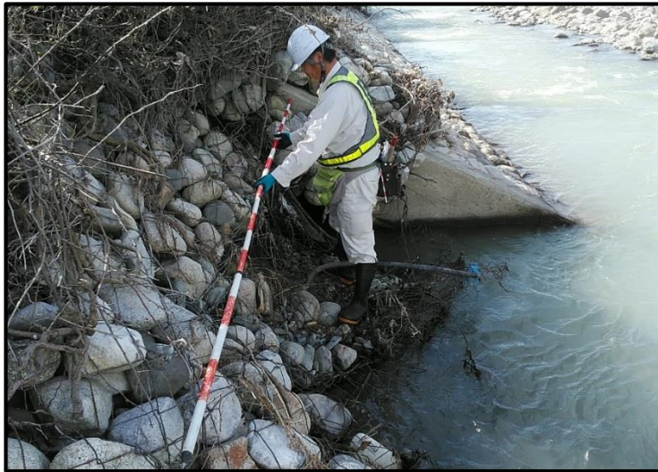
堤防・護岸点検
