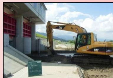
堆積土砂排除
