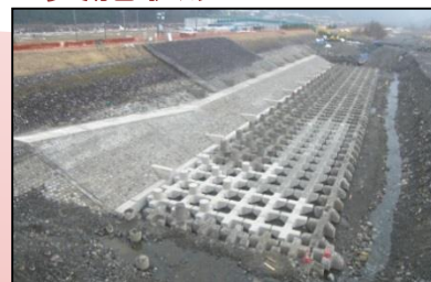
護岸・根固修繕
