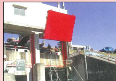
河川管理施設の修繕
