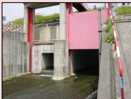
管理施設点検(祝井沢川樋門)
