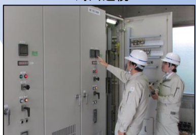
通信設備点検
