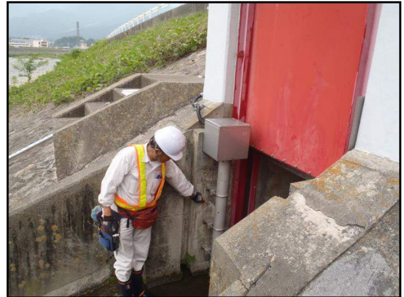
機械設備点検
