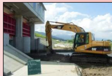
堆積土砂排除
