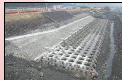
護岸・根固修繕
