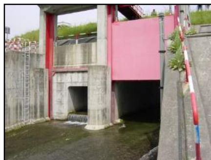
管理施設点検(祝井沢川樋門)
