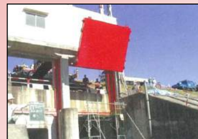
河川管理施設の修繕
