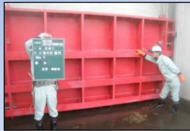
機械設備点検
