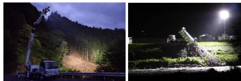
照明車（令和2年7月豪雨対応）
