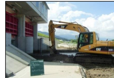
堆積土砂排除
