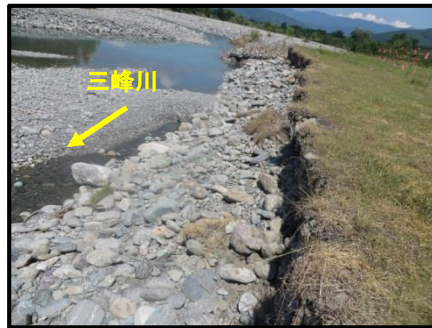
H30.7月 出水 法面侵食
