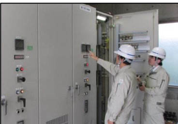
通信設備点検
