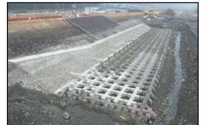
護岸・根固修繕
