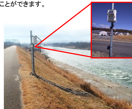
危機管理型水位計の設置状況
