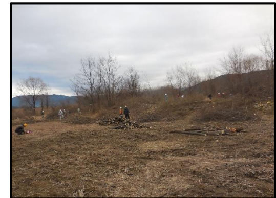
三峰川河川内樹木伐採 (三峰川みらい会議)
