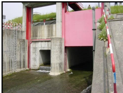
管理施設点検(祝井沢川樋門)
