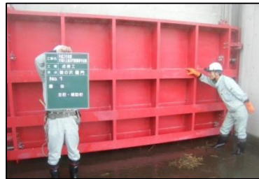
機械設備点検
