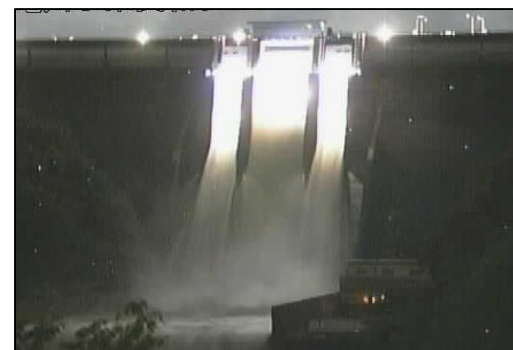
美和ダム放流状況 (10月12日22:19)
