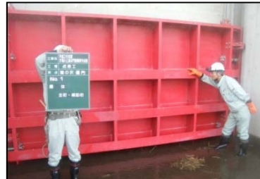
機械設備点検
