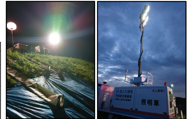
照明車（西日本豪雨排水支援）
