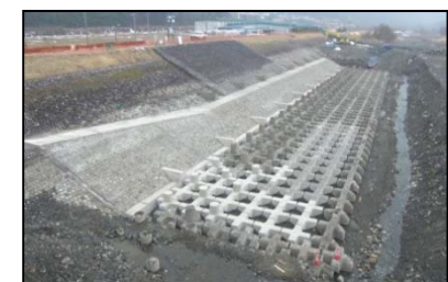
護岸・根固修繕
