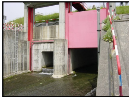
管理施設点検(祝井沢川樋門)
