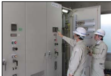
通信設備点検
