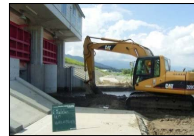
堆積土砂排除
