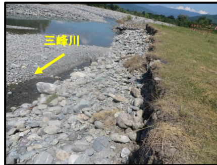
H30.7月 出水 法面浸食
