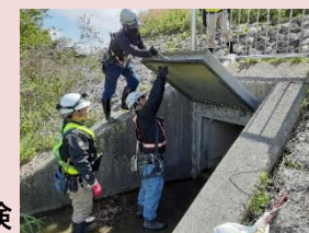
堤防欠損 応急復旧
