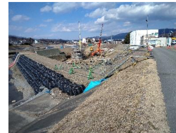
工事の施工状況確認
