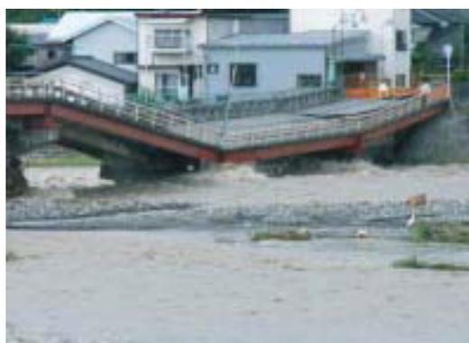
写真 1-11 落橋した殿島橋(伊那市)
