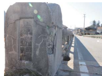
味わいのある親柱だが、傷みが激しい状態
