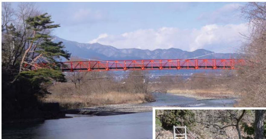
上流の開けた視界に、赤いつり橋が映える (橋の下流から、上流を望む)
