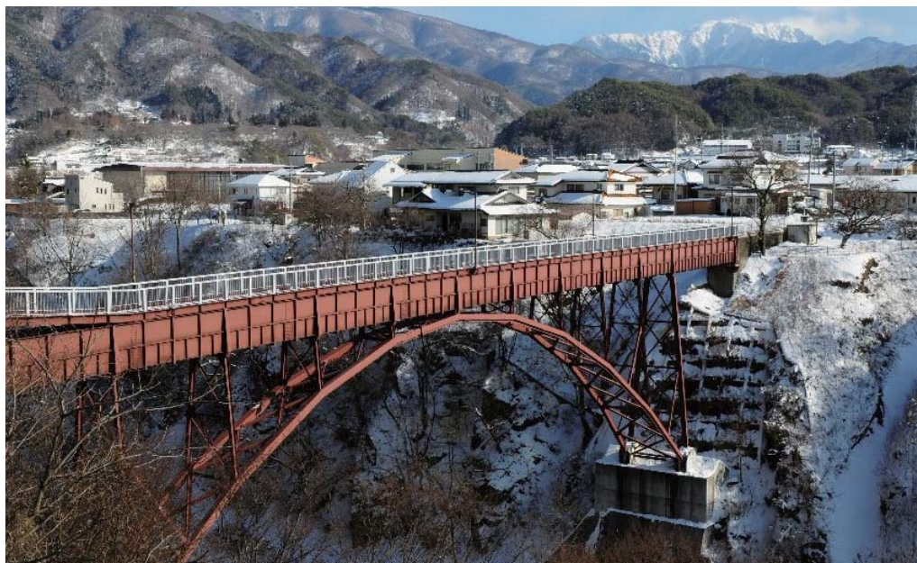
住民意見により茶色に塗装されたアーチ型の橋 ランガー桁と呼ばれる、桁本体を細めのアーチで補強する形式の橋
