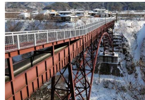
長さ98m、高さ40mにおよぶ橋の上は歩道となっている
