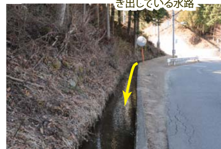
サイフォンにより道路の下を流れ、反対側よりわき出している水路
