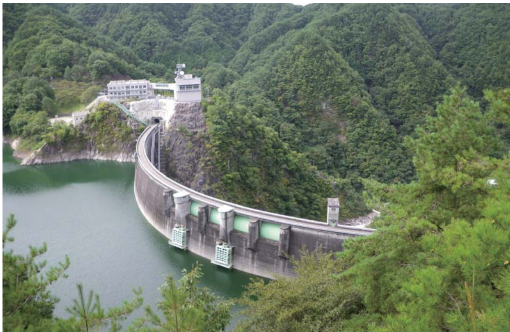
高さ105m、長さ293mのアーチ式コンクリートダム
