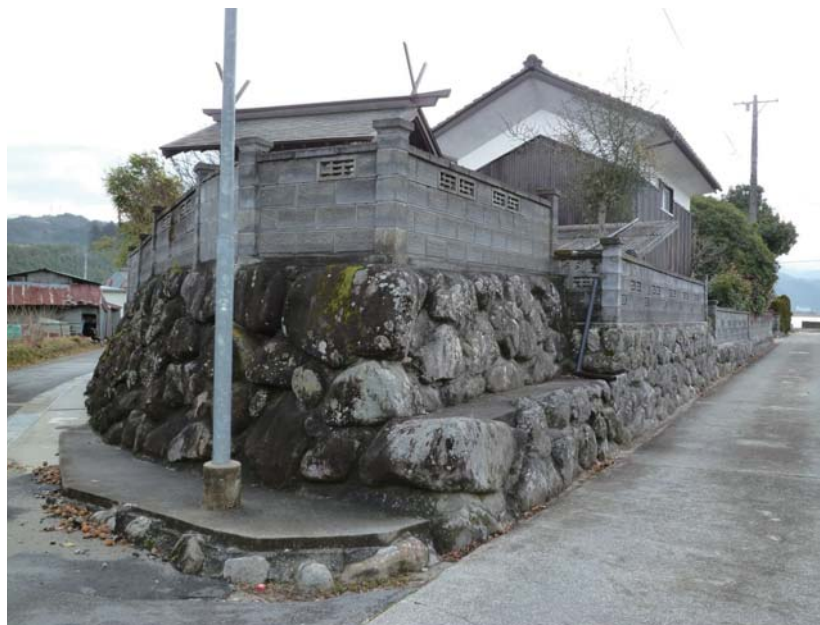
鋭角に組まれた石積みの水除け
