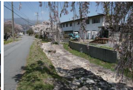
市道の端に位置している石川除
