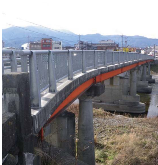
橋の右岸脇に天竜川通運の船着場がある
