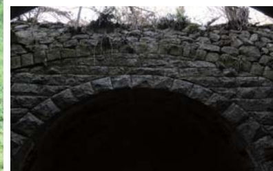
橋面が曲線になっている下流側
