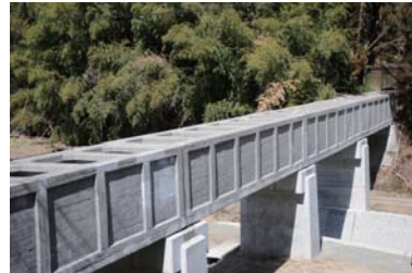
胡麻目沢水路橋
