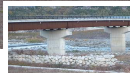
天の中川橋と現在の石堤
