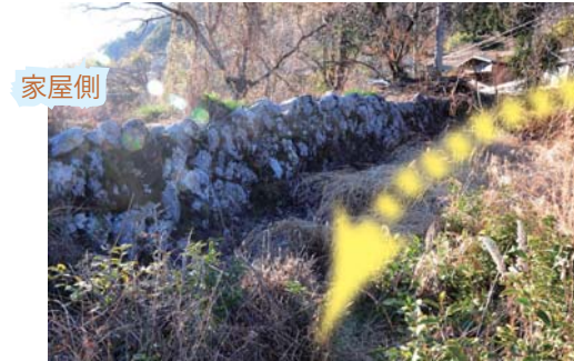
家屋の手前に造られ、山からの土砂の流れを変える
