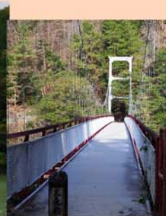
天竜橋の橋面
