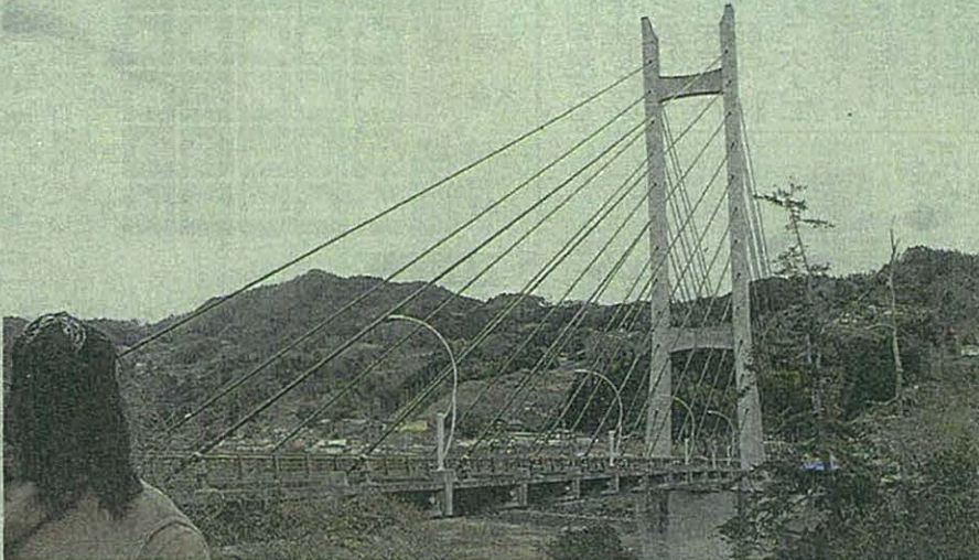
主塔とケーブルの造形が美しい南宮大橋
