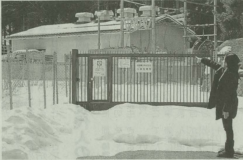
伊那谷で最も古い小黒発電所。伊那市伊那で
