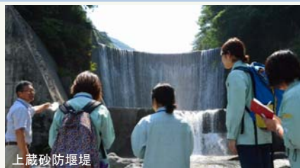
上蔵砂防堰堤
