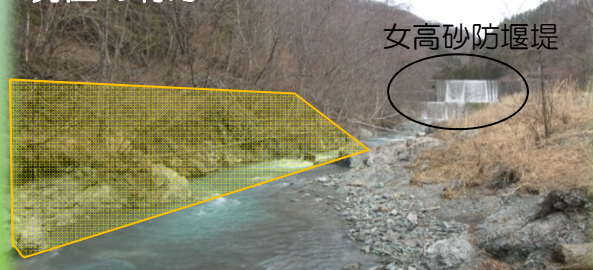
鹿塩川の右岸(西側)が施工範囲となります。
