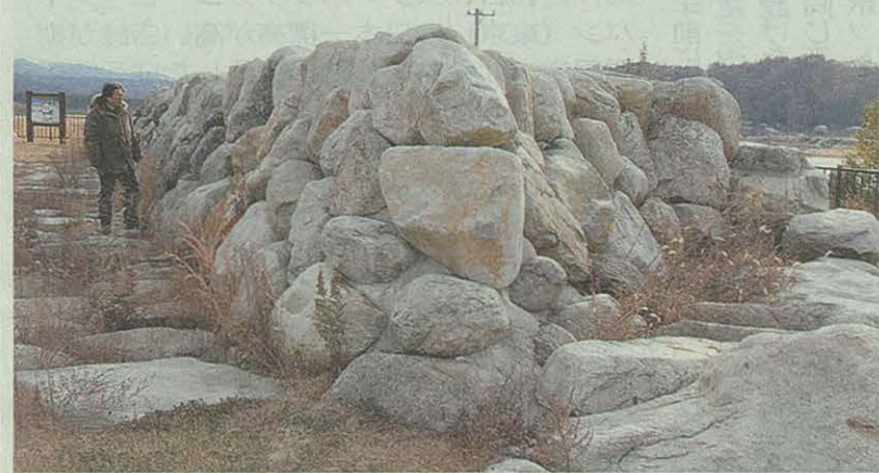
天竜川近くに復元された理兵衛堤防の一部
