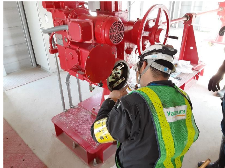
専門業者による機械設備点検
