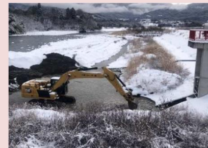
堆積土砂排除
