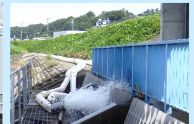
三日町頭首工排水ポンプ車派遣
