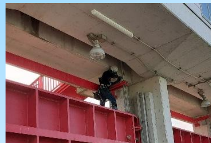
機械設備点検
