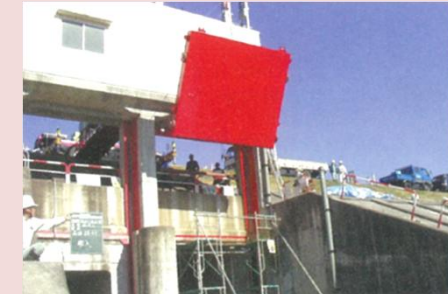
河川管理施設の修繕
