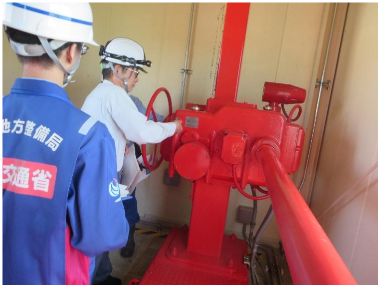
樋門操作講習会の様子（飯田市 祝井沢川排水樋門）
