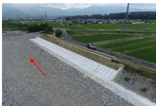
写真 1-14 本復旧完了時
