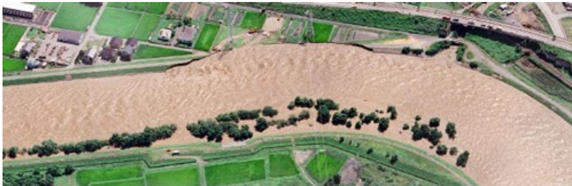
写真 1-10 天竜川本川(箕輪町松島地区)の堤防決壊箇所
