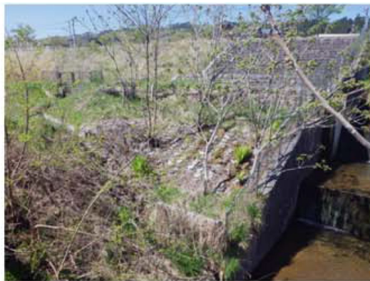
写真 2-2護岸への樹木の侵入状況
