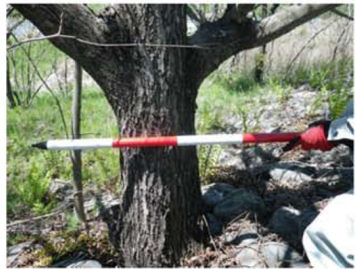
写真 2-2護岸への樹木の侵入状況
