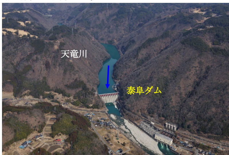
写真 1-6 泰阜ダム付近(飯田地区山間部) (H23年度撮影)
