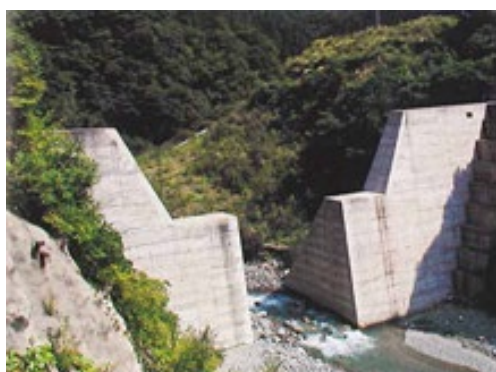
写真 1-21 ③大渡砂防堰堤 大断面スリット(国交省HPより)
