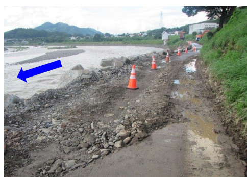
写真 1-16 緊急復旧完了時
