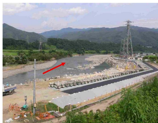
写真 1-12 緊急復旧完了
