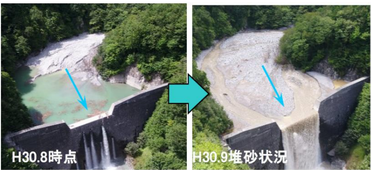
図 飯島第6砂防堰堤(与田切川上流)の堆砂状況
