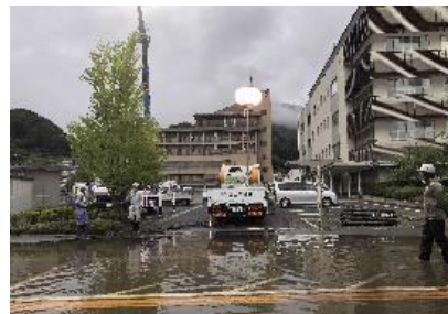
令和3年 諏訪湖浸水被害
