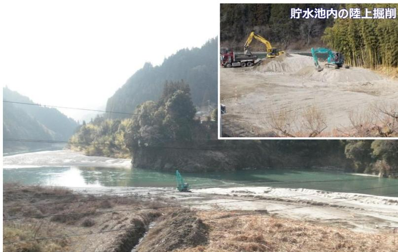
堆砂によるダムの機能低下の例 (湖内の陸上掘削)
