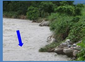
④三峰川右岸4.6k付近 堤防の欠損
