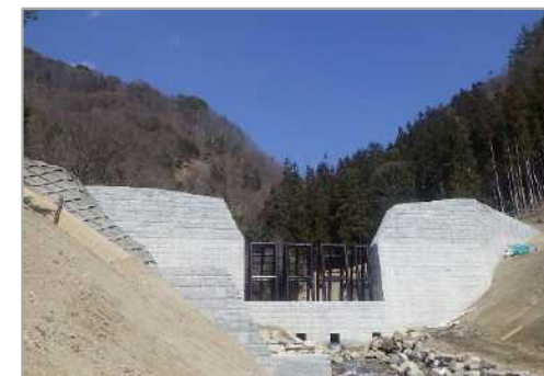
滝沢第2砂防堰堤(大鹿村・中川村)
