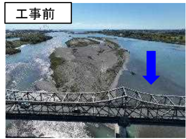
令和4年度天竜川掛塚地区河道掘削工事
