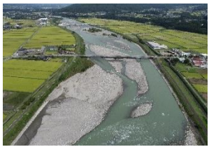
下平3工区付近の礫河原 (R3年9月)
