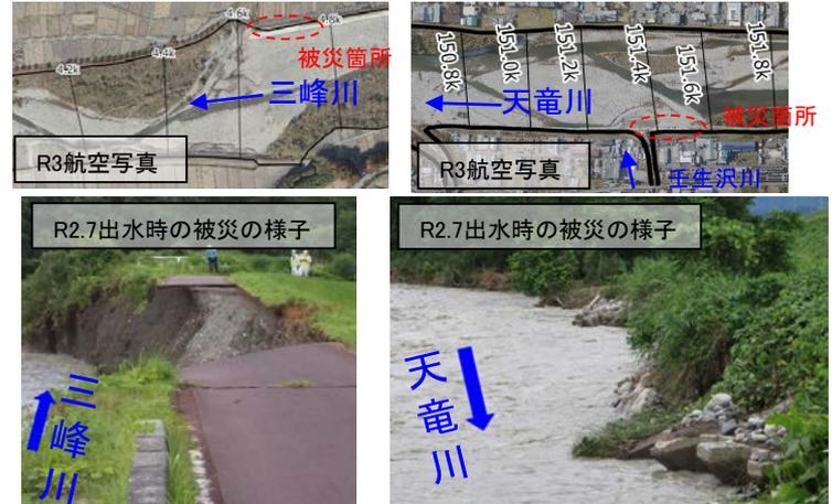
三峰川右岸4.6k付近 堤防の欠損 天竜川左岸151.4k付近 護岸一部流出
