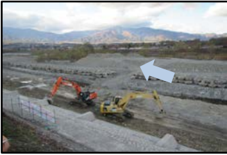
令和3年度 貝沼地区護岸工事 ※実施中
