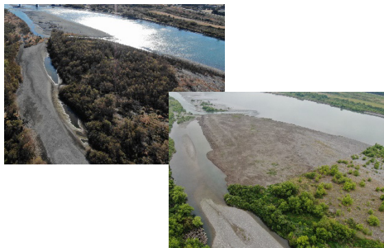
河道内に繁茂した樹木の伐開
