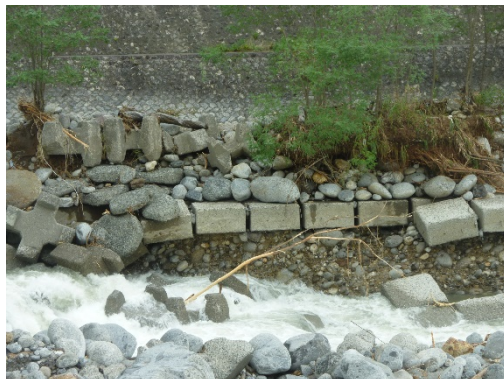
河川管理施設の点検
