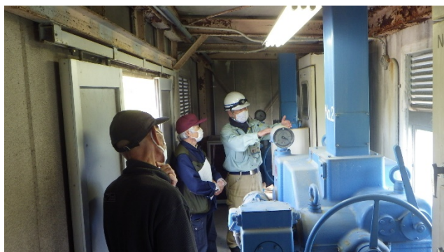
樋門の操作説明会
