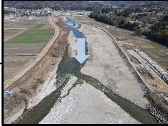
令和2年度 天竜川山吹地区築堤護岸工事 ※R3年度 完成
