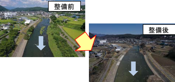
防災・減災、国土強靱化のための3か年緊急対策 令和元年度 天竜川三日町護岸工事
