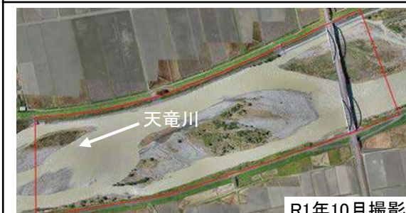
下平地区(1~5工区) (H26-28整備)
