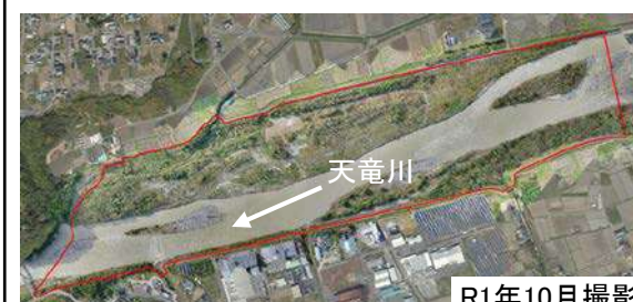
元大島地区 (H20-21整備)
