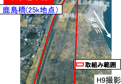
河川敷に階段護岸や高水敷公園が整備されていない
