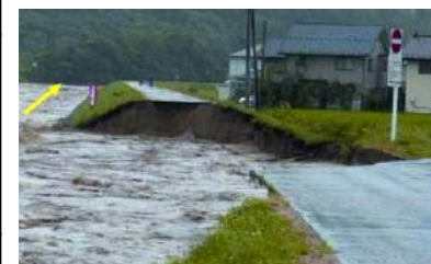
みのわ まつしま (H18.7洪水:箕輪町松島地区) ※天竜川右岸204.8km 堤防決壊箇所
