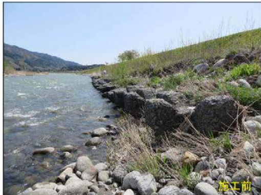
急流対策（根固ブロック及び護岸整備）
