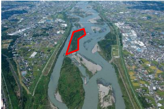
樹木伐開予定箇所（5k付近の例）
